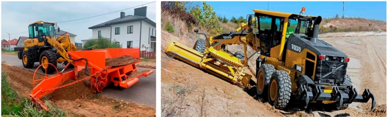
Рисунок 1.1 – Работа при укладке и расширении дорожных обочин
