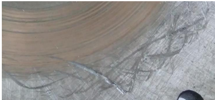
Рис. 87. Следы задира на торцевой крышке насоса
