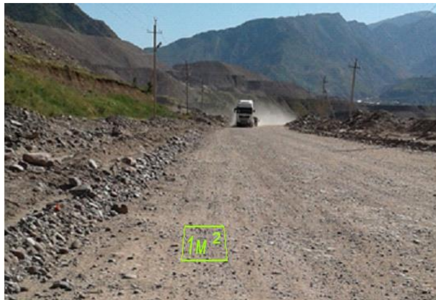
Рисунок 3.2 – Фрагмент горной карьерной автодороги
