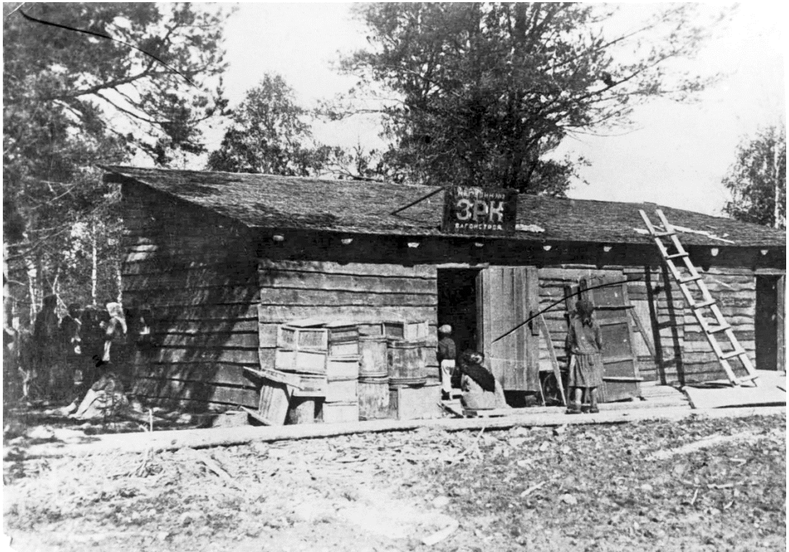
(Первый магазин в районе Вагонстроя в 1932 г.)
