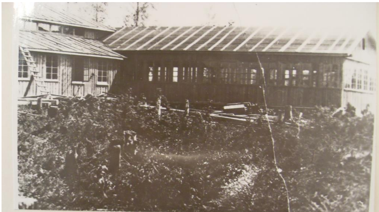
Уралвагонстрой. Правое крыло столовой. На переднем плане пни от срубленных деревьев. 1933 г.
