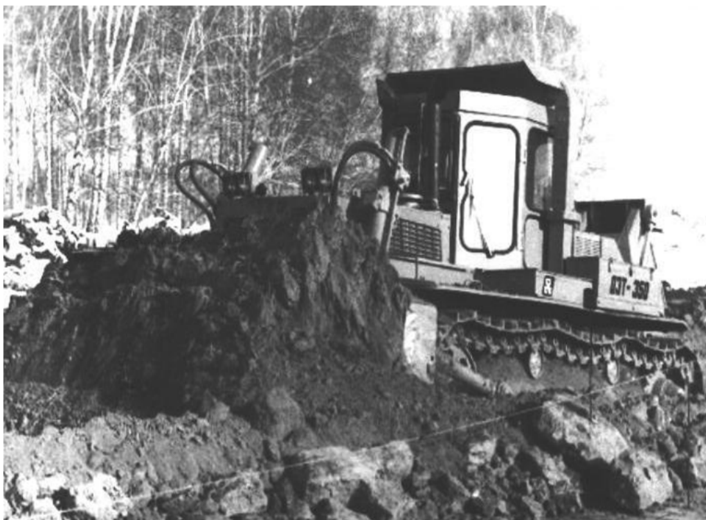
Рис. 5.10. Испытания бульдозера ДЭТ-350 при разработке траншеи
