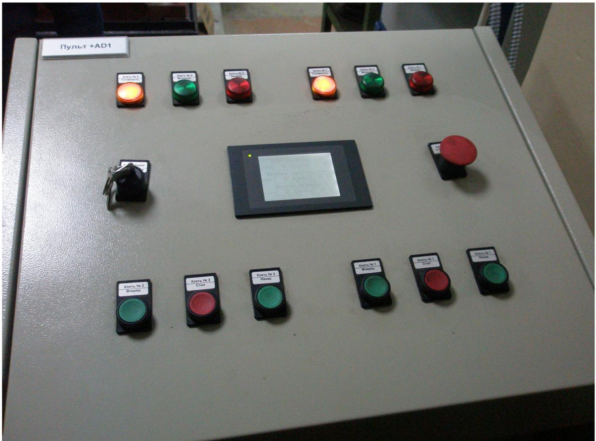
Рис. 3.4. Многофункциональная операторская панель MAC-E410 с сенсорным экраном
