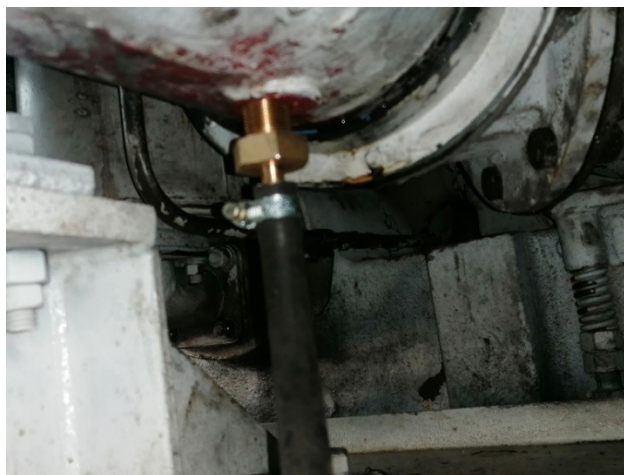
Рисунок 4.3 – Монтаж распыливающего устройства во впускной коллектор двигателя тепловоза
