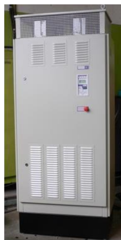
Рисунок 13 – а) ВНС-2, 400 кВт, 0.69 кВ; б) Шкаф ПЧ СЧ500 250 кВт, 0.69 кВ
