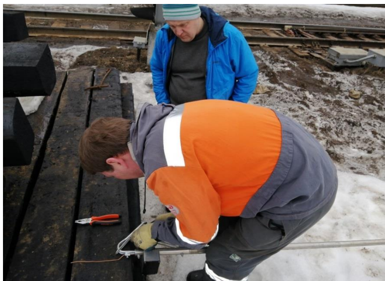
Рисунок 3.13 – Монтаж контролирующего устройства на переносную заземляющую штангу контактной сети
