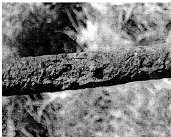
Рисунок 1.1 – Сочетание язвенных и локальных коррозионных повреждений
