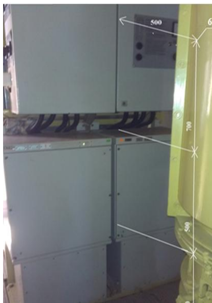
Рисунок 1.25 – Машинное отделение - шкаф БВА-3
