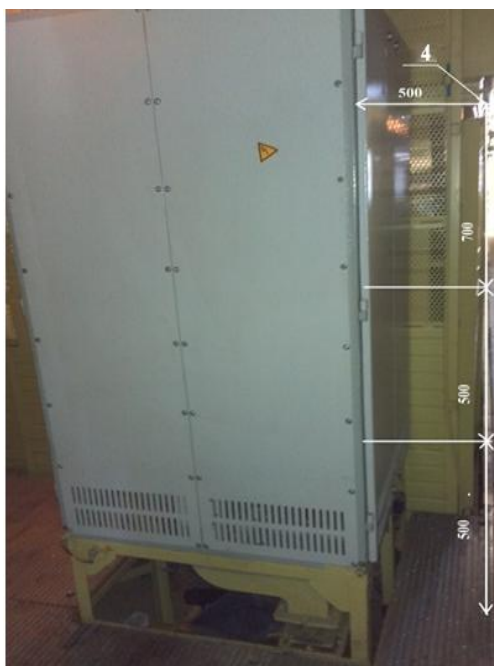
Рисунок 1.19 – Машинное отделение - шкаф БАУ
