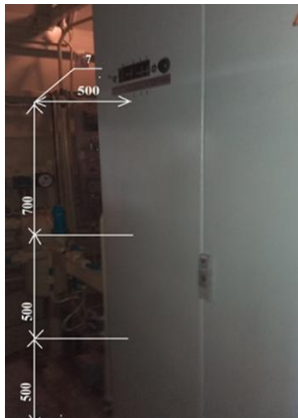
Рисунок 1.28 – Машинное отделение - шкаф БВА-2
