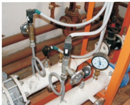
Рис. 7. Автоматизированные тепловые пункты зданий ЮрГУ
